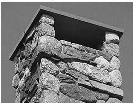
Stone Cap Chimney Top
